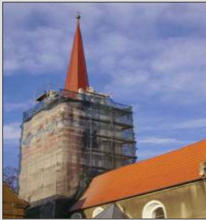
Wieża podczas prac remontowych
